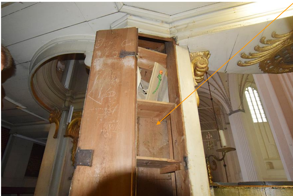
3: Nördliche Ständerkonstruktion am Mittelbau. Zwei parallele Ständer, verkleidet und mittig als Schrank ausgebaut.
