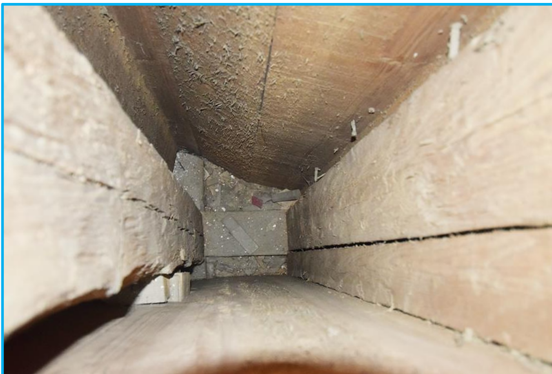
3: Blick von oben in das verkleidete untere Ständerpaar.
