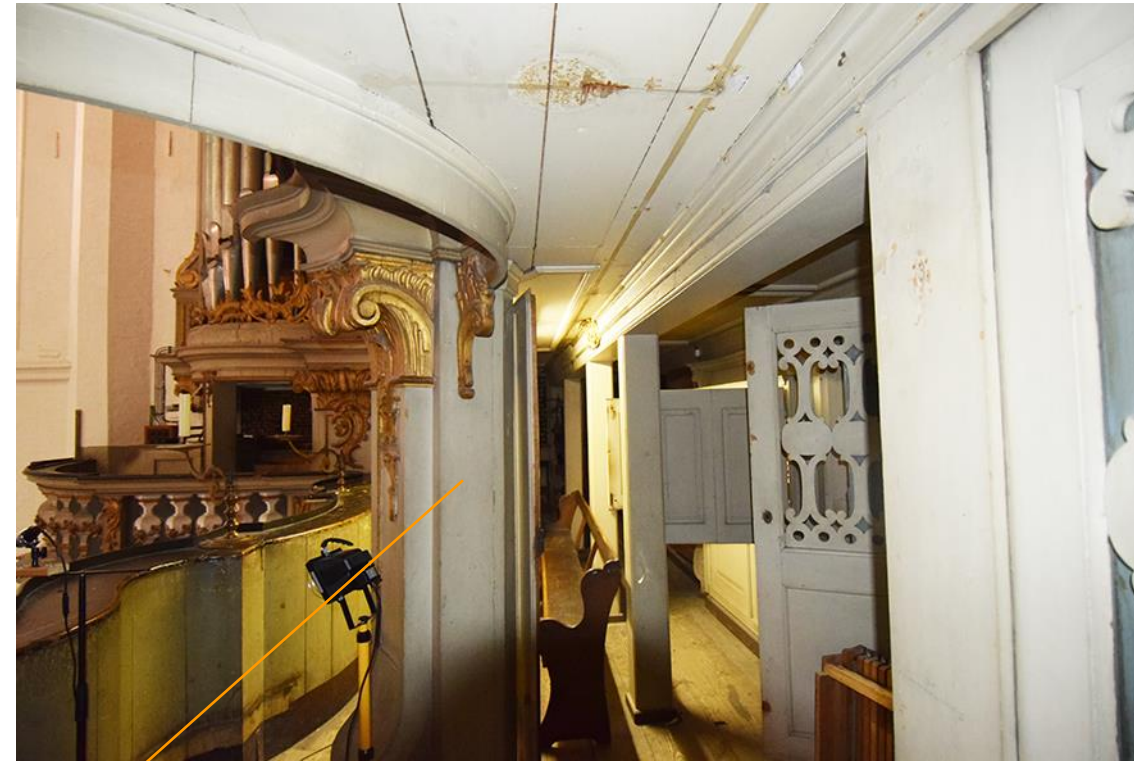
2: vgl. Bild 1: Plattform Mittelteil, Blick nach S.
