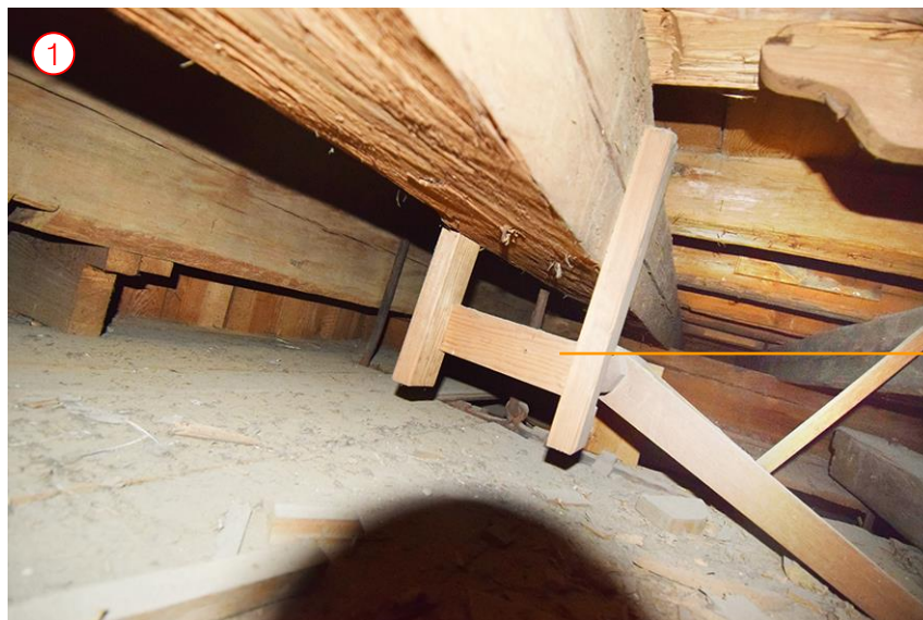
Blick nach S, in die Konstruktion des Mittelteils. Unterhalb anschließend das Tragwerk des Baldachins.
