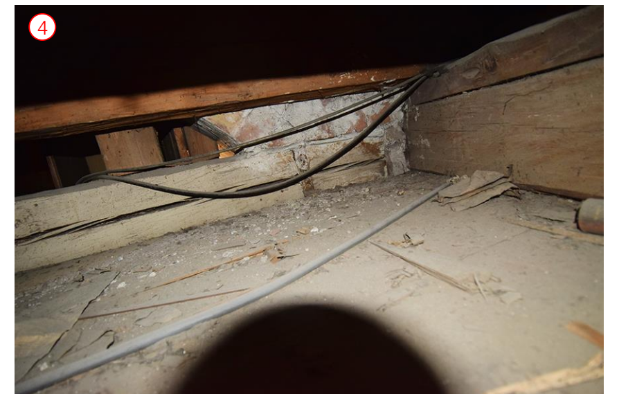
Blick nach W, zum Turm, rechts der im Turmmauerwerk gelagerte Tragbalken
