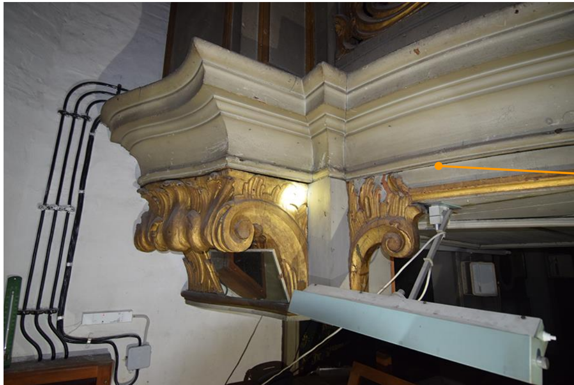
1: Konstruktion an sich analog zu Nordseite (siehe vorige Seiten), aber untere Ständer für Spieltisch von 1937 entfernt (!)
