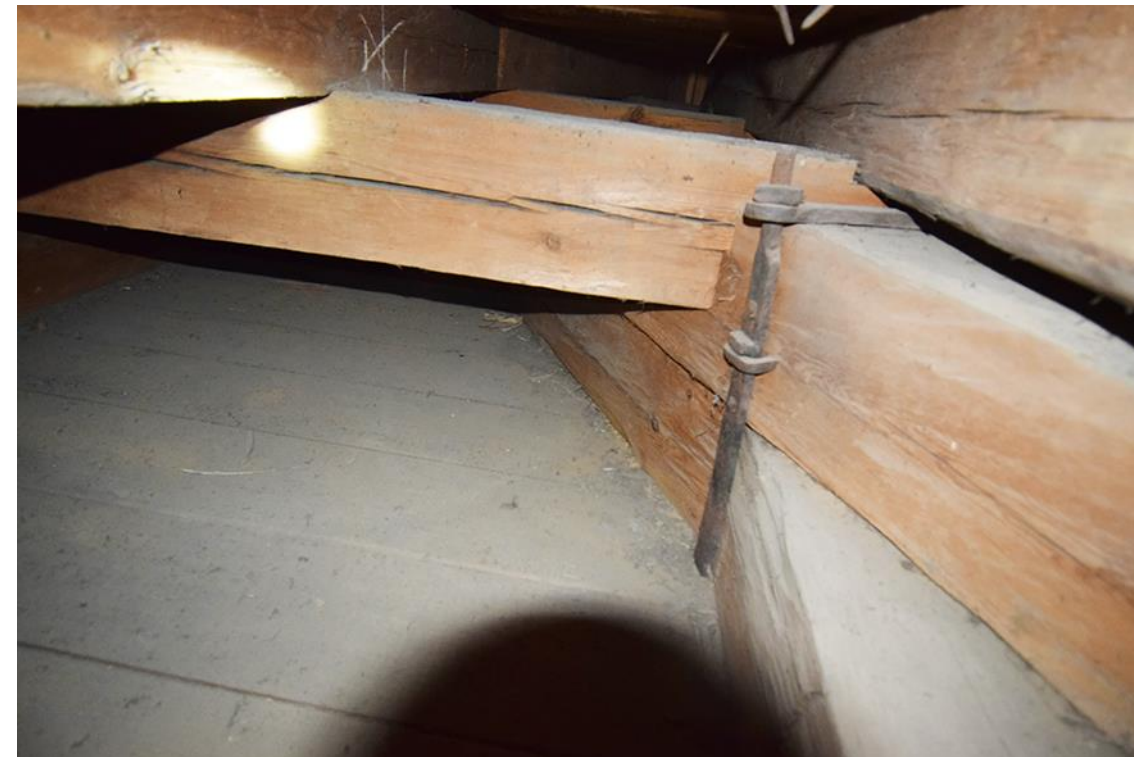
3: Blick nach O, in den Nordflügel, mittig die Sicherung der Abstrebung.
