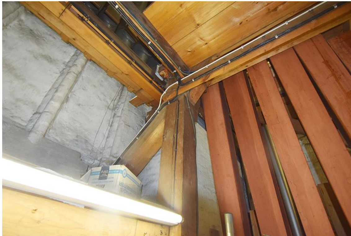
1 und 2: Mittelteil, westliche Konstruktionsachse. Große, sprengwerksartige Abstrebung des abschließenden oberen Orgelaufbaus zu den Außenmauern. Nordseitig (Bild 2) zusätzlich ergänzte untere Strebe.
