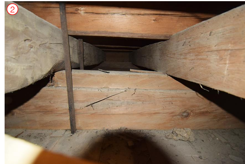
Blick nach S, unten der Tragbalken mit der Zapfensicherung für die Abstrebung
