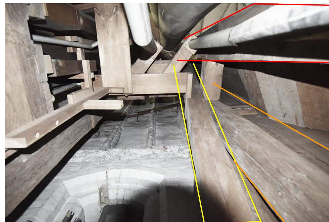
4: Blick nach oben/Norden in die Öffnung
