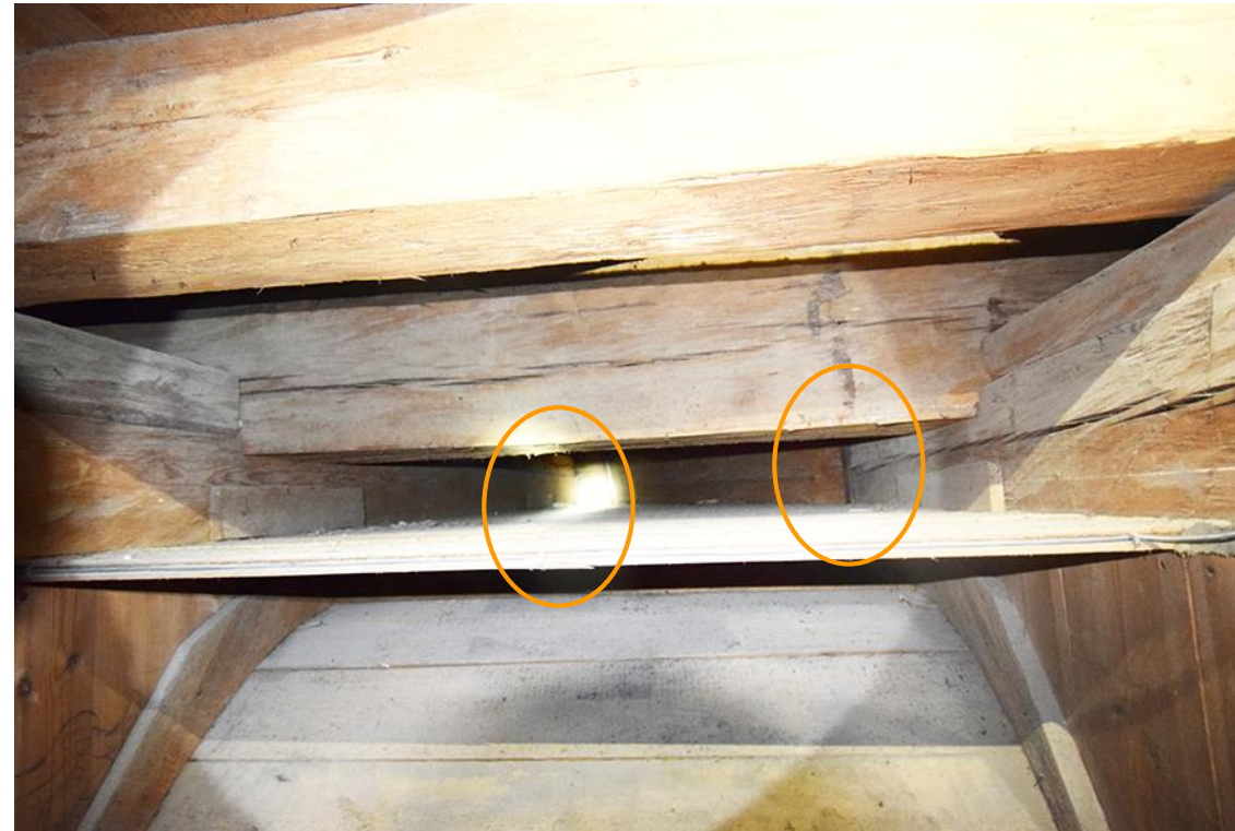
2: Blick in das Tragwerk Unterbau am Nordflügel, unten die Verbretterung der Raumschale. Markiert die Eisensicherungen der Abstreibungen.
