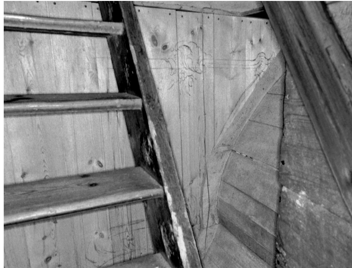
4: Treppenaufgang auf die Orgelplattform. An der Verbretterung wohl bauzeitlicher Entwurf für die Gestaltung der Raumschale.
