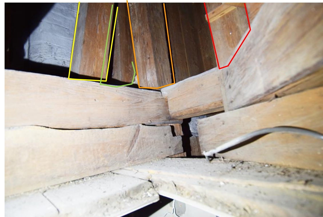
2: Ebene 1., Blick auf den Stockwerkswechsel von den unteren zu den oberen Ständerabschnitten mit Schwell-/Riegelkonstruktion
