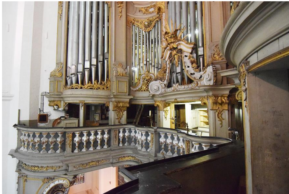
1: Blick vom Nordflügel zum Mittelteil der Orgelplattform. Orgelaufbau mit verkleideten Ständern auf den Unterbau gesetzt.
