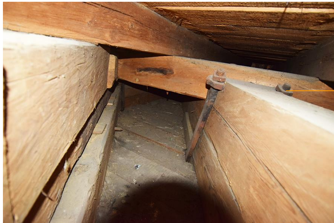
2: Blick nach Westen. Rechts die bauzeitliche Eisen-Sicherung zwischen Abstrebung und Tragbalken (Lagesicherung Zapfen/Versatz)
