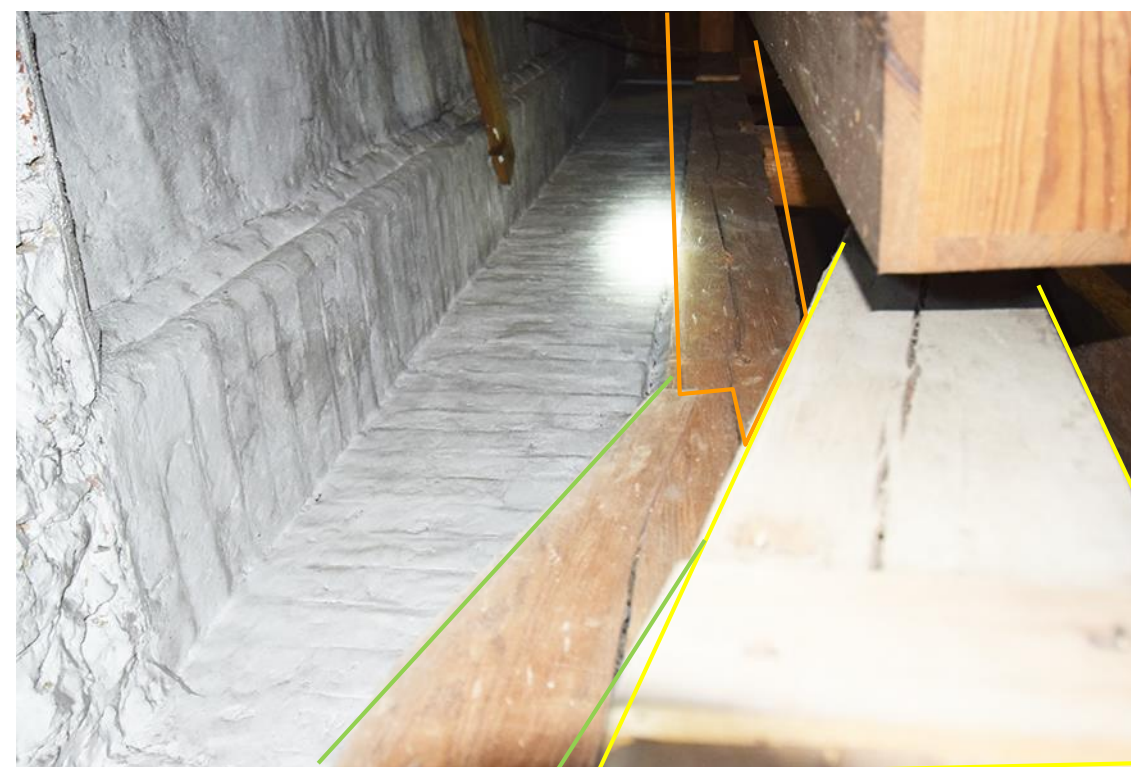
4: Nordostecke, mit Abstreben der beiden oberen Ständersr auf die Mauerbank des Triforiums.
