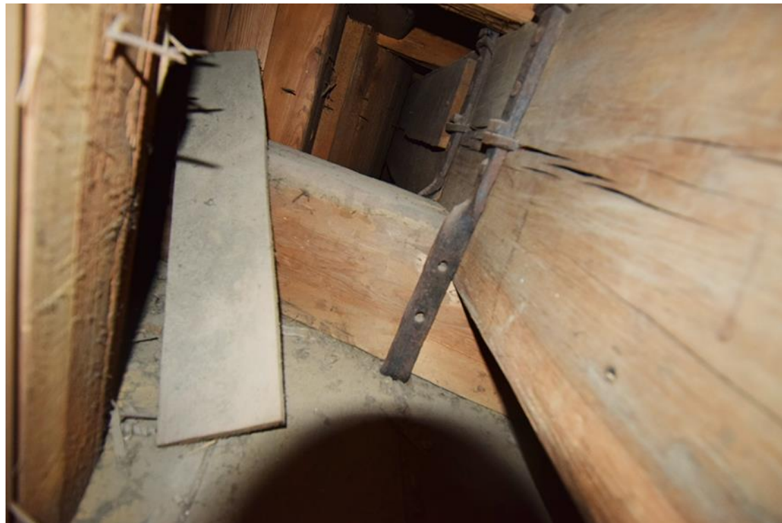
2: Blick nach S, links die Brüstung der Orgelplattform, mittig die Sicherung der Abstrebung.
