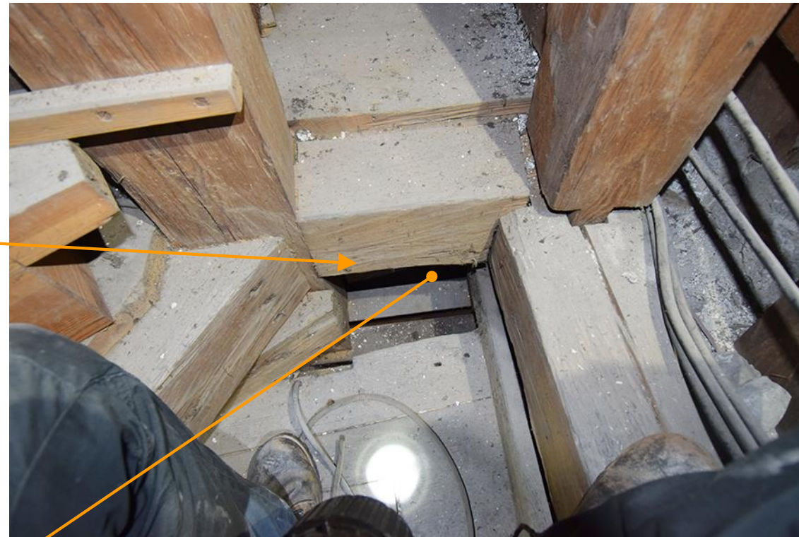
2: Blick von oben auf die Ebene 1 mit dem Wechsel zwischen oberen und unteren Ständern
