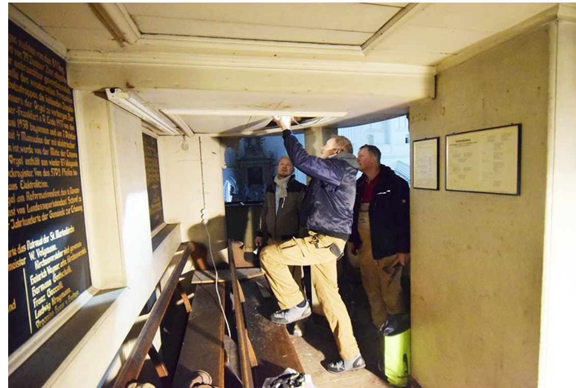
2: Nordflügel, Blick nach O, Durchführung der Bauteilöffnung.
