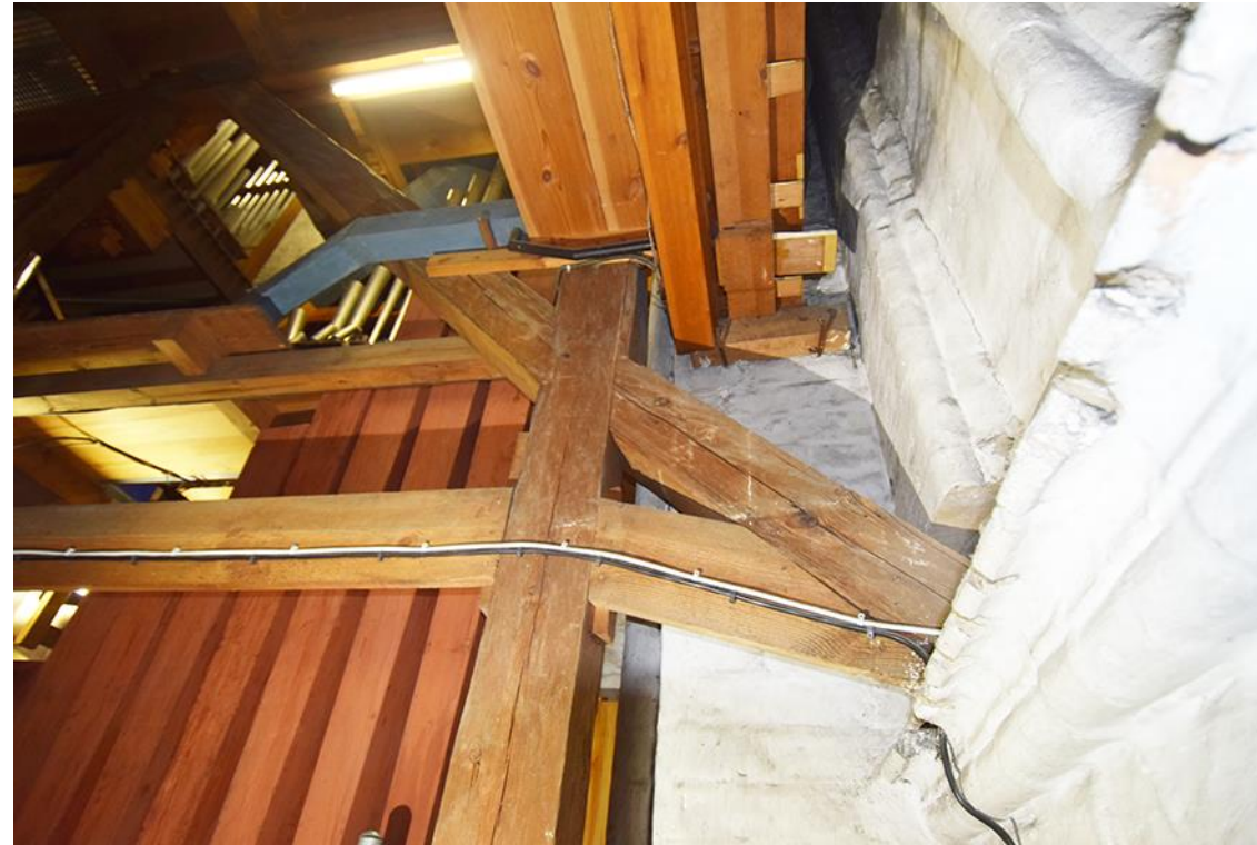
1 und 2: Mittelteil, westliche Konstruktionsachse. Große, sprengwerksartige Abstrebung des abschließenden oberen Orgelaufbaus zu den Außenmauern. Nordseitig (Bild 2) zusätzlich ergänzte untere Strebe.
