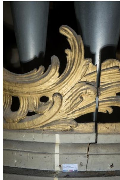
Eisenhalterung und Holzkonstruktion
