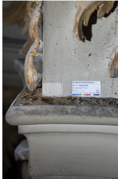
Holzmehl und Bohrlöcher
