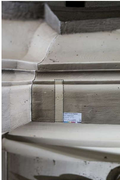
gereinigte Sichtfassung von 1843
