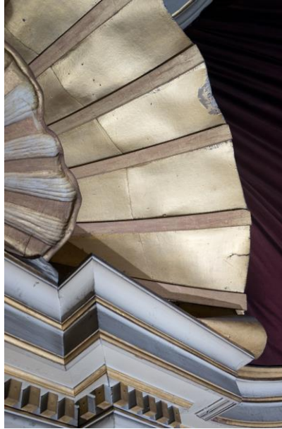
beschädigtes Pappmachéelement
