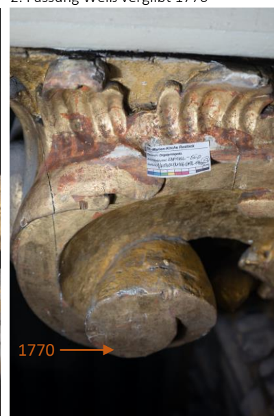
2. Fassung Polimentvergoldung 1770 am Kapitell des Orgelprospekts
