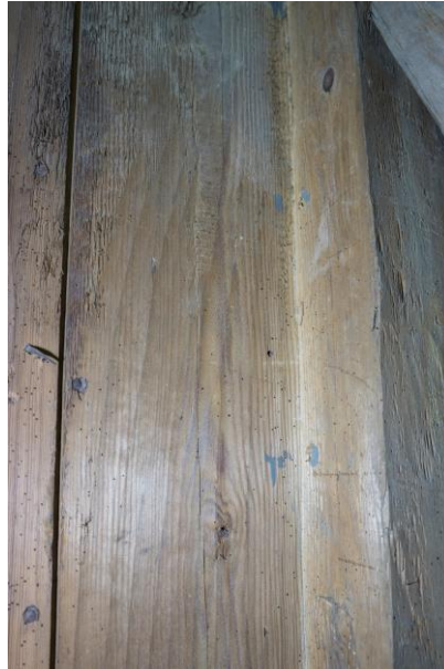
Holzschutzmittel Rückwand Orgelprospekt
