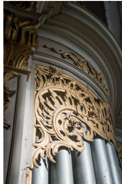
delaminierte bauzeitliche Leimfugen
