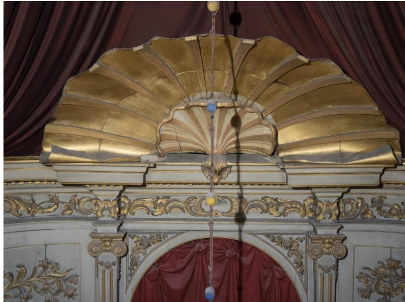
Pappmachéeuschel mit Strukturschwächungen, Rissen und Vergoldungsfehlstellen bauzeitliche Fenstergläser 1751
