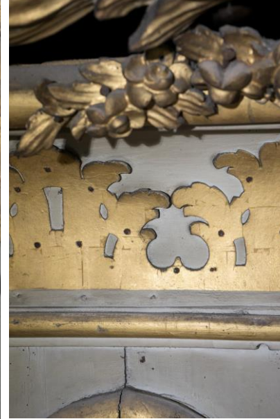
korrodierende Eisennägel
