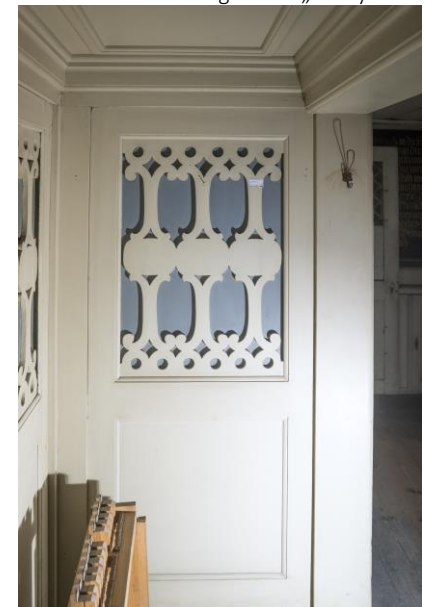
5. Fassung an erneuerter Rücklage in Grau hell und Blau rötlich an der Orgelempore
