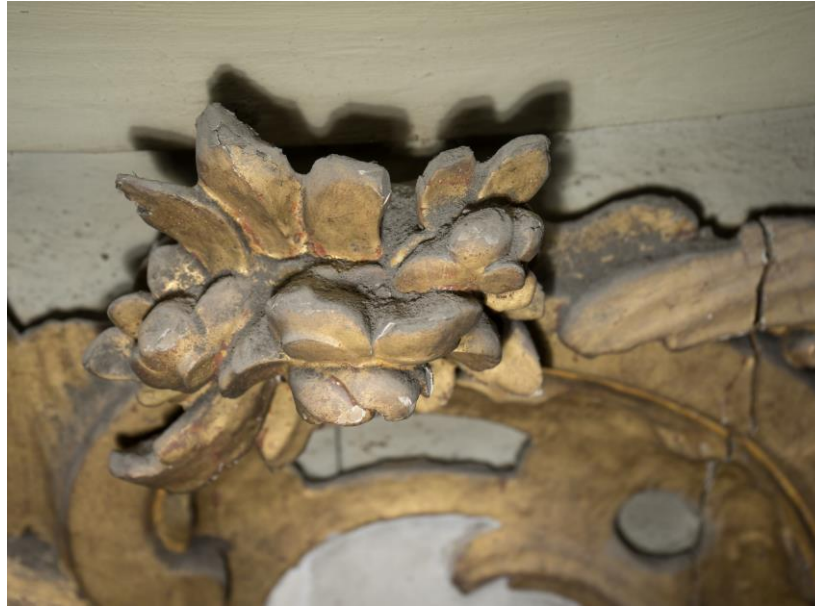
gelöste barocke Vergoldungen mit Fehlstellen
